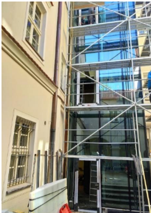
Zdj. 2 Budowa windy – stan na dzień 03.06.2020 r.
