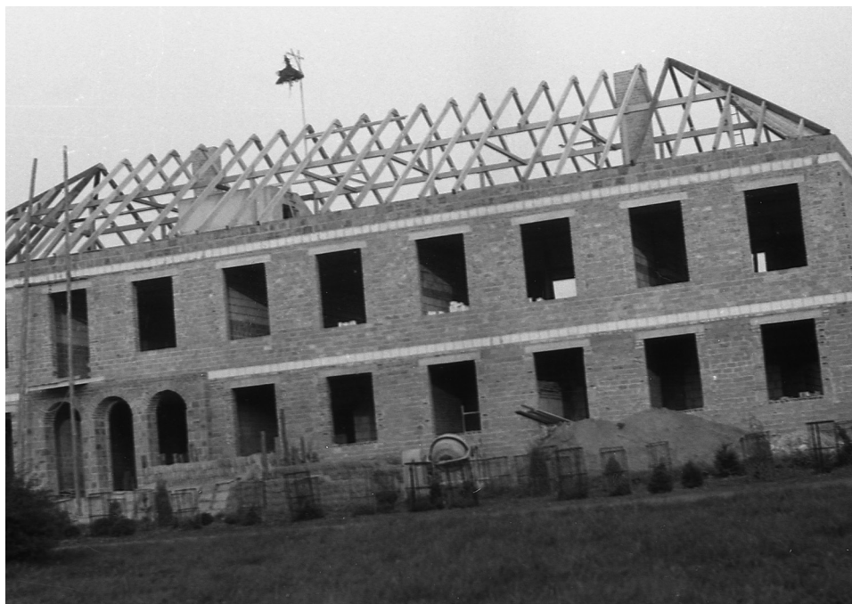
Budowa budynku B Instytutu, 1984 (fot. Elżbieta Szubert)
