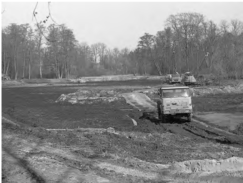
Prace konserwatorskie w Arboretum Kórnickim – odsłanianie i oczyszczanie stawu, 1978 (fot. Kazimierz Jakusz)
